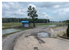
Before 道路補修（小山市内）
