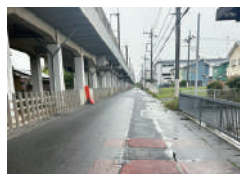
Before 道路補修（小山市内）
